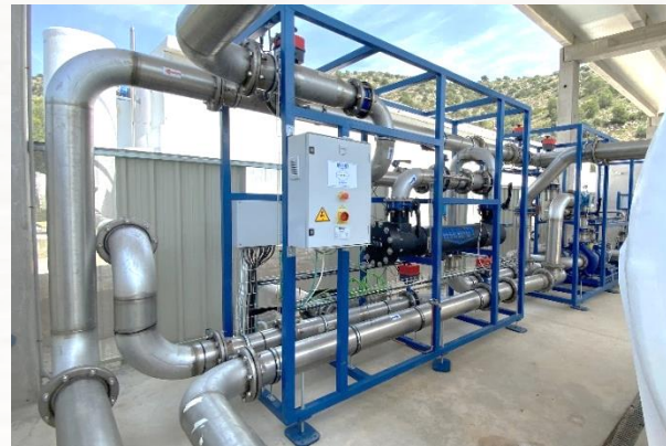
SKID / MODULOS PREFABRICADOS
