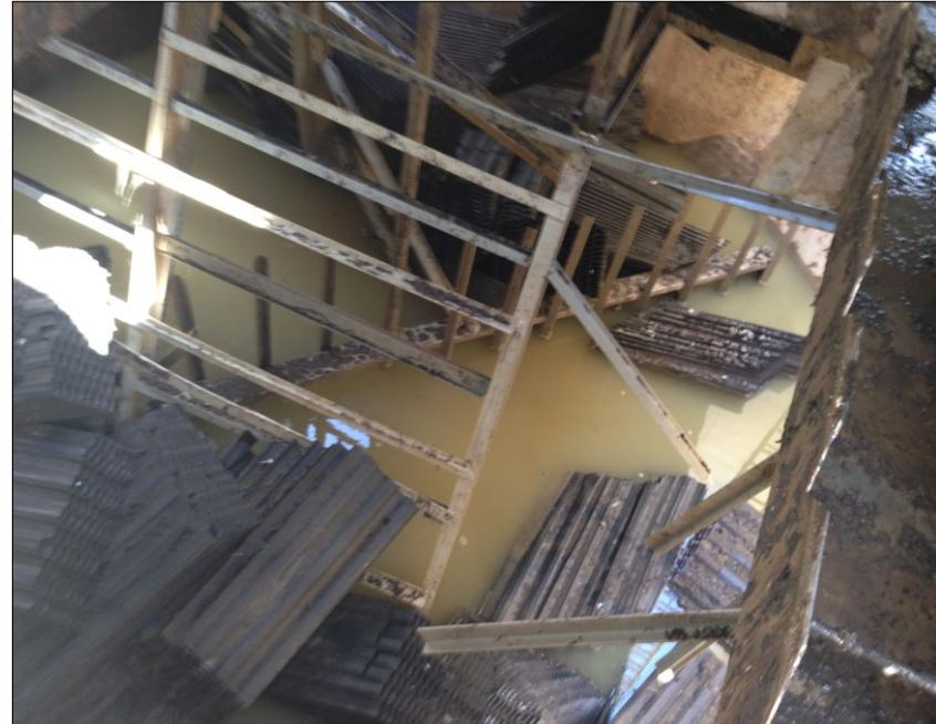
No instalación de un sistema anti-flotación.
