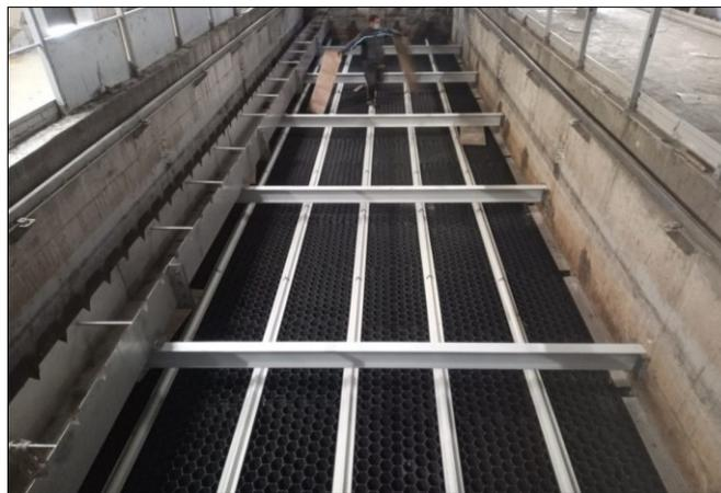
*Lamelas con sistema anti-flotación.*
