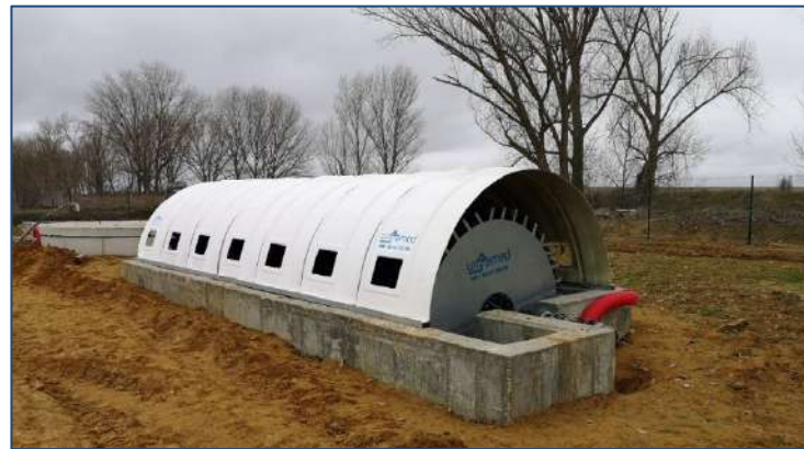
E.D.A.R. VILLABRAGIMA – (Valladolid, España) AÑO: 2026 – Un biodisco. MDL: 230-600-3
