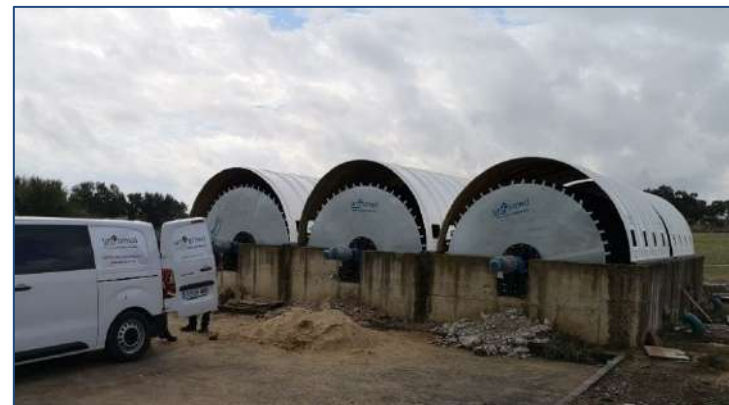
E.D.A.R MIRANDILLA– (Badajoz, España) AÑO: 2024 – Seis biodiscos. MDL: 295-400-1
