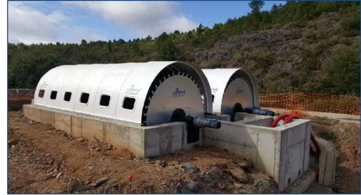
E.D.A.R ALCAÑICES (Zamora, España) AÑO: 2021 – Dos biodiscos. MDL: 255-500-3
