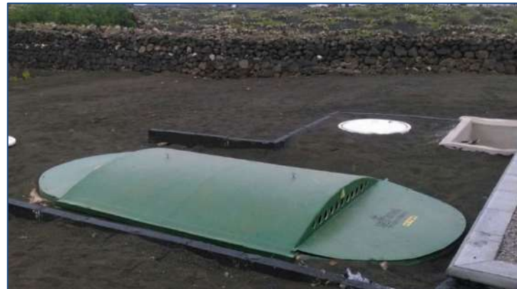
E.D.A.R CANARIAS (Lanzarote, España) Año: 2015 - Un biodisco. MDL: 160-200-2 (bañera compacta de PRFV)
