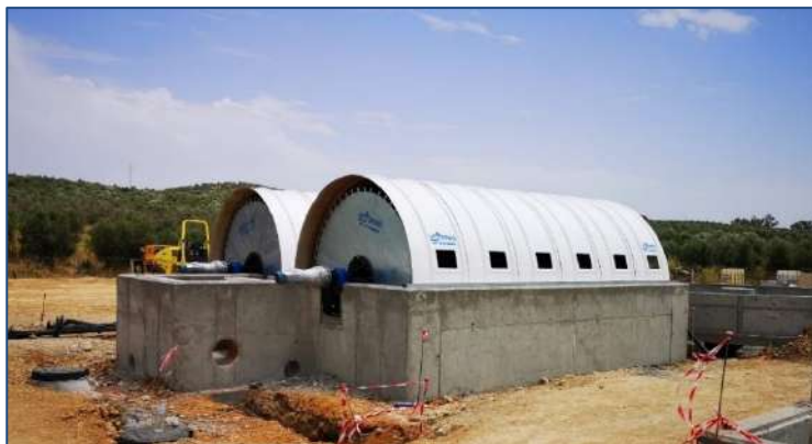
E.D.A.R. GUADALCAZAR – (Córdoba, España) AÑO: 2025 - Dos biodiscos. MDL: 295-550-3
