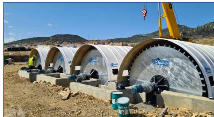
E.D.A.R PEÑALSORDO–(Badajoz, España) AÑO: 2023 –Cuatro biodiscos. MDL: 295-600-3
