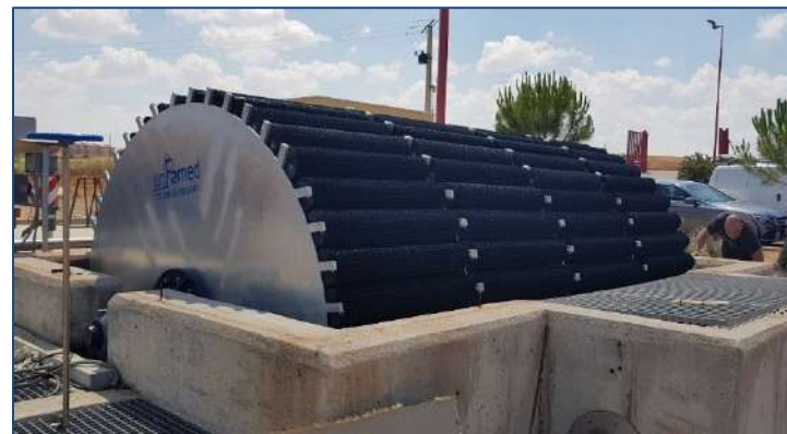
E.D.A.R CABEZAMESADA (Toledo, España) AÑO: 2018 – Rehabilitación de un biodisco. MDL: 255-400-1
