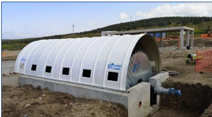
E.D.A.R CAZALILLA–(Jaén, España) AÑO: 2024 - Un biodisco. MDL: 295-550-3
