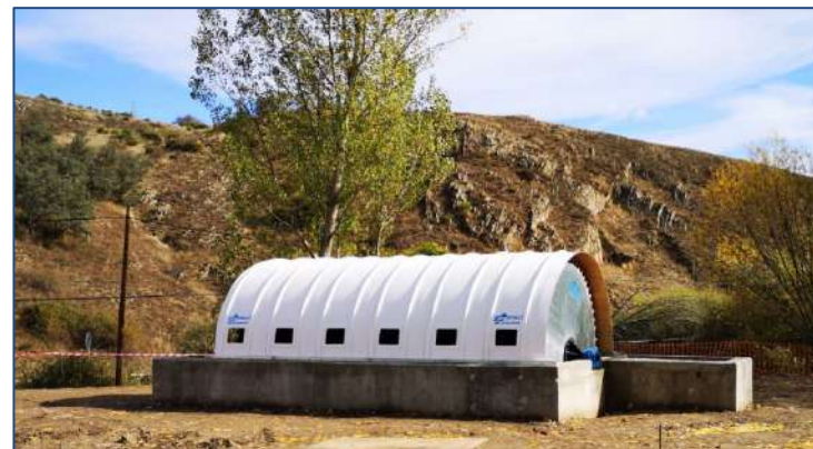
E.D.A.R. CANALES - LA MAGDALENA – (León, España) AÑO: 2025 – Un biodisco. MDL: 360-550-3
