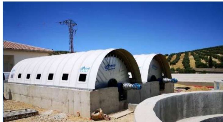
E.D.A.R FUERTE DEL REY – (Jaén, España) AÑO: 2024 – Dos biodiscos. MDL: 255-600-3
