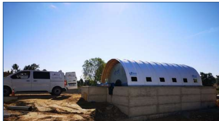
E.D.A.R. FUENTETOBA – (Soria, España) AÑO: 2025 – Un biodisco. MDL: 295-550-3
