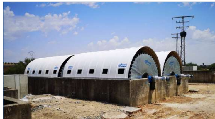
E.D.A.R. TRUJILLANOS – (Badajoz, España) AÑO: 2025 – Dos biodiscos. MDL: 295-550-1/295-550-2
