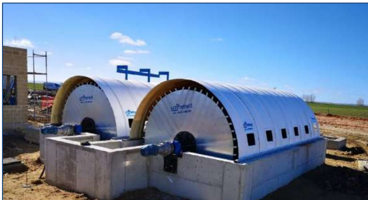
E.D.A.R. SANCHIDRIÁN – (Ávila, España) AÑO: 2024 - Dos biodiscos. MDL: 295-550-3
