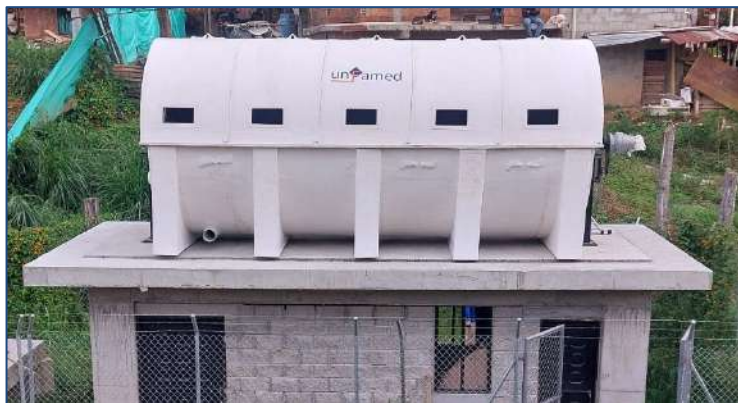
E.D.A.R. GALICIA POBLADO – (Río Negro, Colombia) AÑO: 2025 - Un biodisco. MDL: 230-450-4
