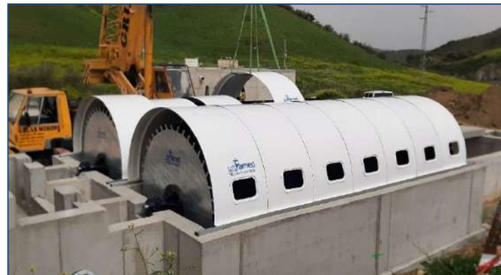
E.D.A.R VILLANUEVA DE SAN JUAN (Sevilla, España) AÑO: 2018 – Dos biodiscos. MDL: 255-600-3
