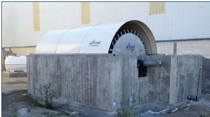
E.D.A.R MORALES DEL VINO (Zamora, España) AÑO: 2014 - Un biodisco. MDL 230-300-3
