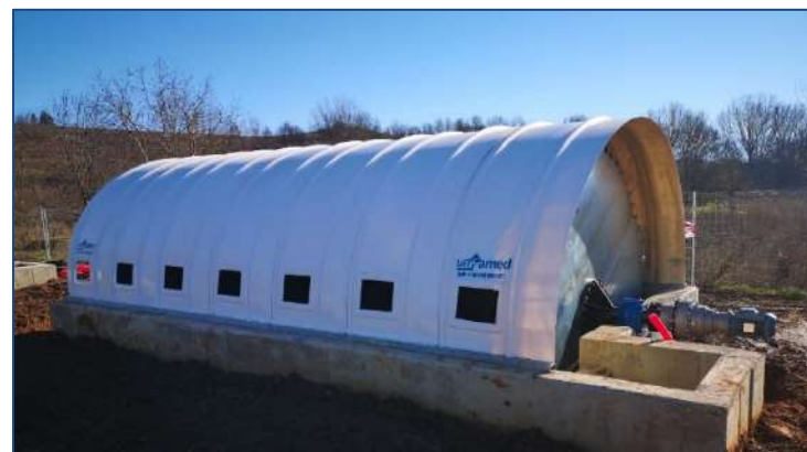
E.D.A.R. VALTUILLE– (León, España) AÑO: 2024 – Dos biodiscos. MDL: 360-300-3
