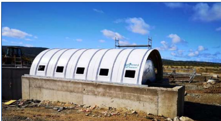
E.D.A.R FUENTERROBLE DE SALVATIERRA– (Salamanca, España) AÑO: 2024 - Un biodisco. MDL: 230-450-3
