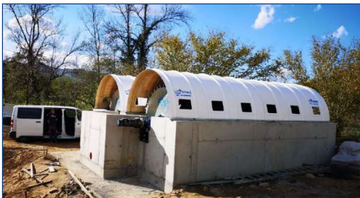
E.D.A.R. MESTAS DE CON – (Asturias, España) AÑO: 2025 - Dos biodiscos. MDL: 230-500-3
