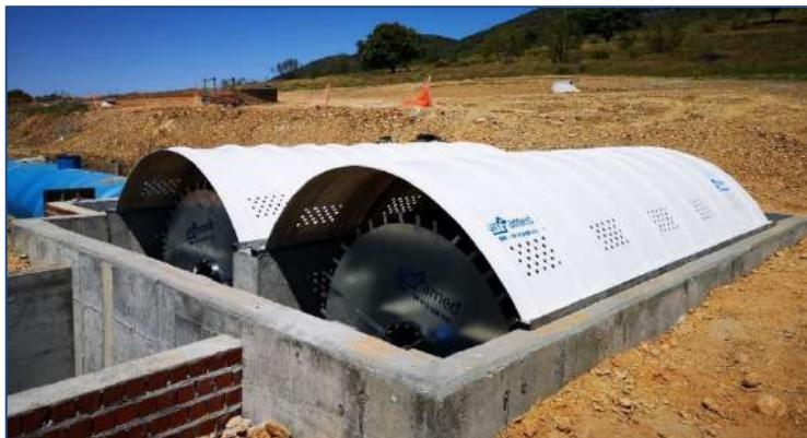
E.D.A.R. TRASIERRA – (Badajoz, España) AÑO: 2025 - Dos biodiscos. MDL: 230-400-3
