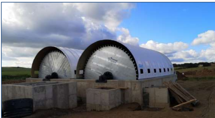
E.D.A.R NAVA DE SANTIAGO –(Badajoz, España) AÑO: 2023 - Dos biodiscos. MDL: 395-600-4
