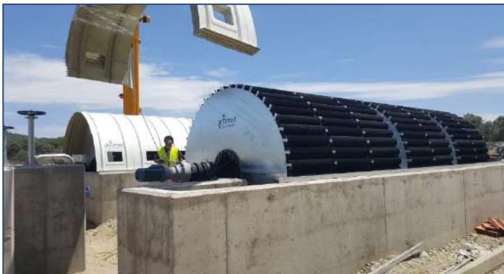
E.D.A.R DELEITOSA–(Cáceres, España) AÑO: 2023 - Dos biodiscos. MDL: 295-700-3
