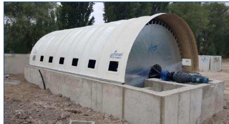
E.D.A.R VILLARIEZO–(Burgos, España) AÑO: 2023 – Un biodisco. MDL: 295-700-3
