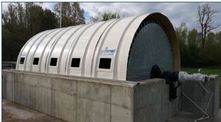
E.D.A.R. VECILLA DE CURUEÑO – (León, España) AÑO: 2025 - Un biodisco. MDL: 360-450-4
