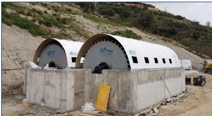
E.D.A.R. SOPORTUJAR – (Granada, España) AÑO: 2025 - Dos biodiscos. MDL: 255-550-3
