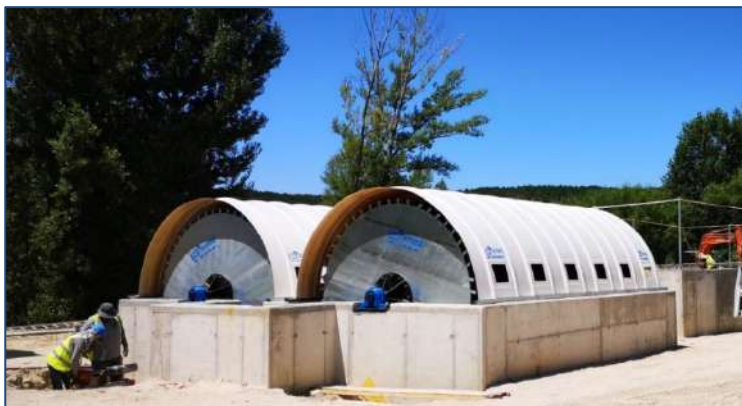
E.D.A.R. HUERTA DEL REY – (Burgos, España) AÑO: 2025 - Dos biodiscos. MDL: 295-550-3
