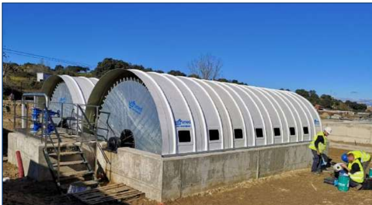
E.D.A.R CARCABOSO –(Cáceres, España) AÑO: 2023 - Dos biodiscos. MDL: 360-700-3
