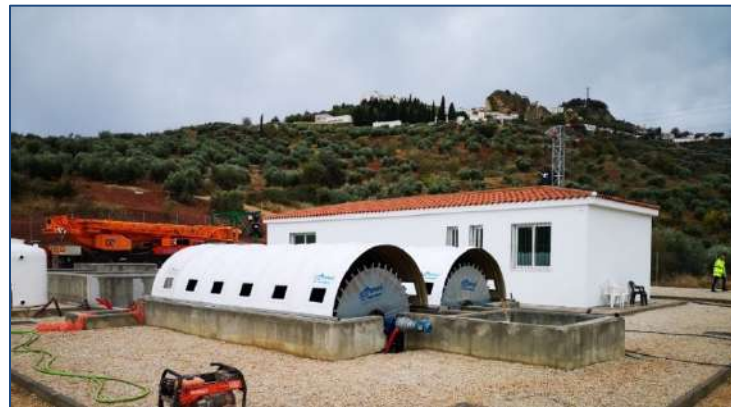
E.D.A.R. CHICLANA DE SEGURA – (Jaén, España) AÑO: 2024 – Dos biodiscos. MDL: 230-550-3
