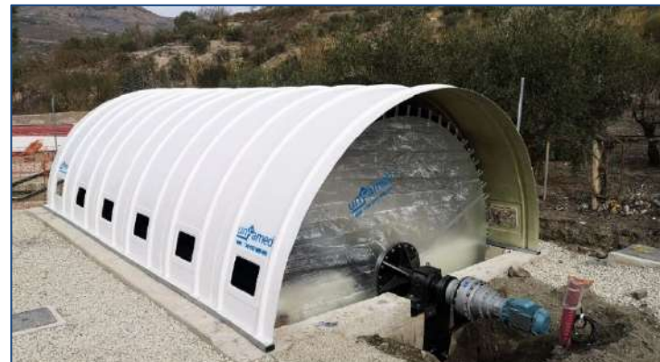
E.D.A.R TORVIZCON –(Granada, España) AÑO: 2023 – Un biodisco. MDL: 360-500-3
