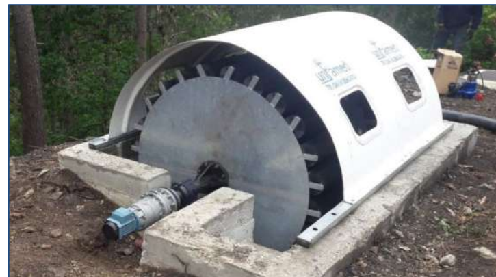
E.D.A.R CASTAÑERAS (Asturias, España) AÑO: 2019 –Un biodisco. MDL: 160-150-2
