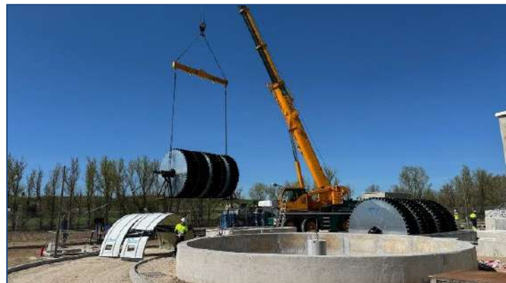
E.D.A.R GUADAHORTUNA – (Granada, España) AÑO: 2024 – Dos biodiscos. MDL: 360-450-3
