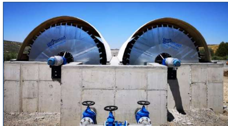
E.D.A.R. CUEVAS BAJAS – (Málaga, España) AÑO: 2025 – Dos biodiscos. MDL: 255-550-3
