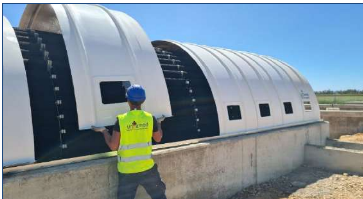
E.D.A.R VALDIVIA –(Badajoz, España) AÑO: 2023 - Dos biodiscos. MDL: 360-650-4
