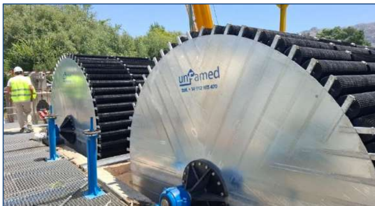
E.D.A.R. VILLANUEVA DEL ROSARIO – (Málaga, España) AÑO: 2025 - Dos biodiscos. MDL: 360-500-1/360-450-2
