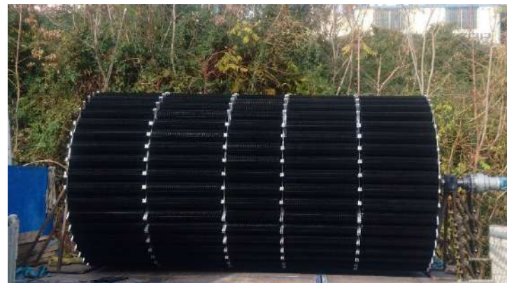
E.D.A.R MANZANIL (Loja, Granada) Año:2016 - Un biodisco. MDL: 255-475-1
