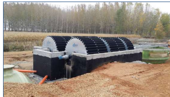
E.D.A.R LAGUNA DE NEGRILLOS (León, España) AÑO: 2018 – Dos biodiscos. MDL: 255-500-3
