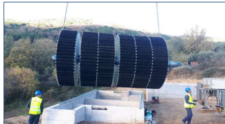
E.D.A.R POYALES DEL HOYO –(Ávila, España) AÑO: 2023 – Un biodisco. MDL: 360-600-3
