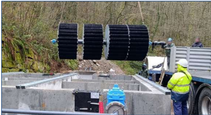
E.D.A.R. TRIACASTELA – (Lugo, España) AÑO: 2026 - Dos biodiscos. MDL: 195-400-3
