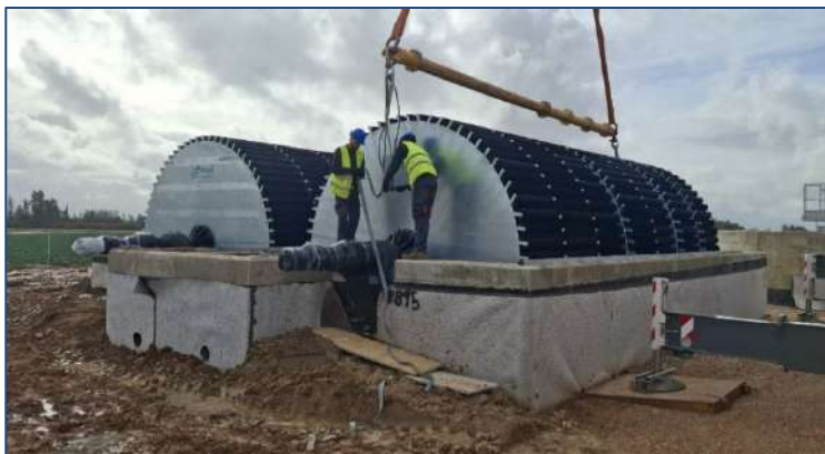
E.D.A.R. VILLAR DE RENA – (Badajoz, España) AÑO: 2026 - Dos biodiscos. MDL: 395-700-4
