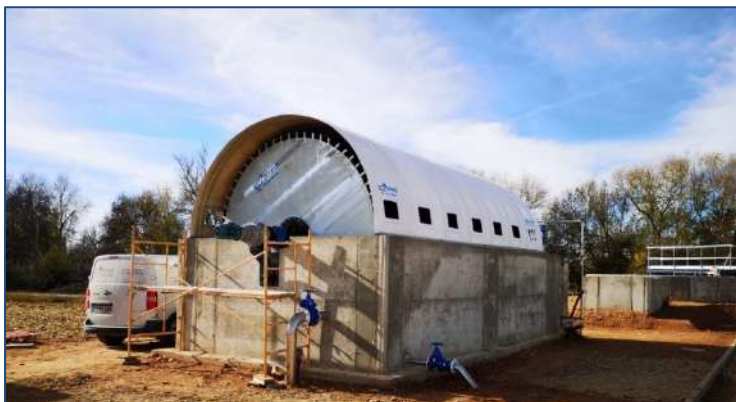
E.D.A.R. ALDEALENGUA– (Salamanca, España) AÑO: 2024 - Un biodisco. MDL: 360-600-3
