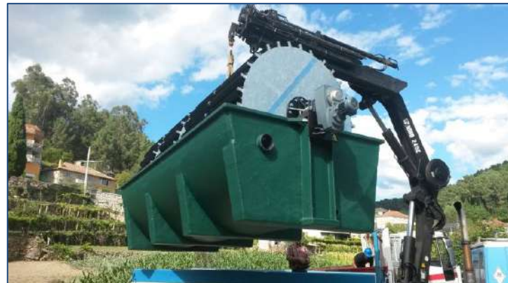
E.D.A.R PONTE BARXAS (Ourense, España) AÑO: 2014 – Un biodisco. MDL: 195-400-3 (bañera de PRFV)
