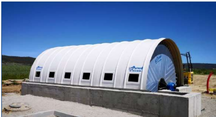
E.D.A.R. MUÑANA – (Ávila, España) AÑO: 2025 - Un biodisco. MDL: 360-550-3
