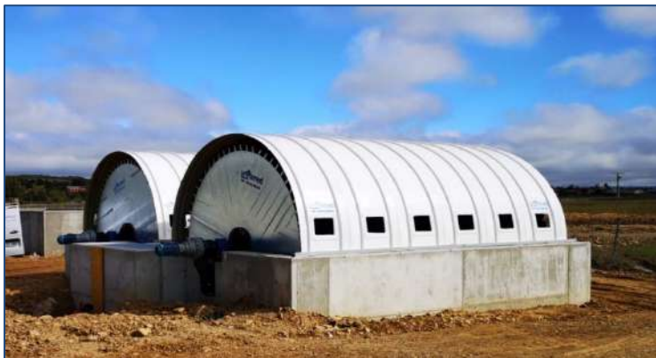
E.D.A.R IBEAS DE JUARROS– (Burgos, España) AÑO: 2024 - Dos biodiscos. MDL: 360-550-3
