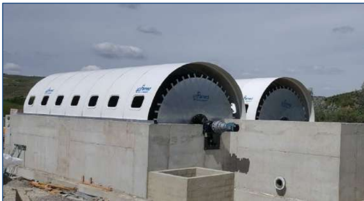
E.D.A.R ALGÁMITAS (Sevilla, España) AÑO: 2021 – Dos biodiscos. MDL: 255-600-3.
