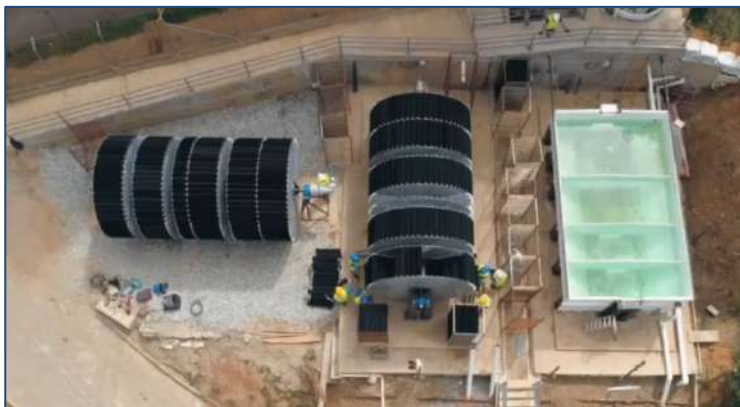
E.D.A.R. SANTA ELENA – (Medellín, Colombia) AÑO: 2025 - Dos biodiscos. MDL: 360-550-4
