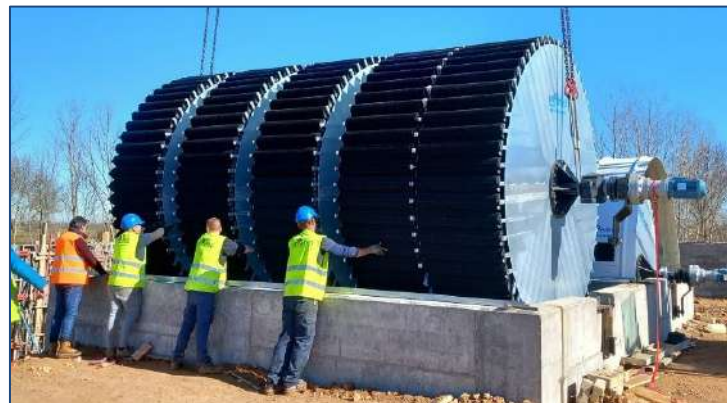
E.D.A.R SANCTI ESPIRITUS–(Salamanca, España) AÑO: 2024 – Dos biodiscos. MDL: 360-500-4
