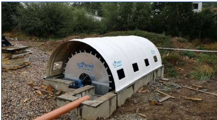
E.D.A.R ROBLES DE VALCUEVA – (León, España) AÑO: 2024 - Un biodisco. MDL: 195-300-3
