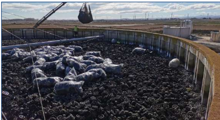
E.D.A.R BAJO EBRO (Navarra, España) 919 m3 SYSTEM-P
