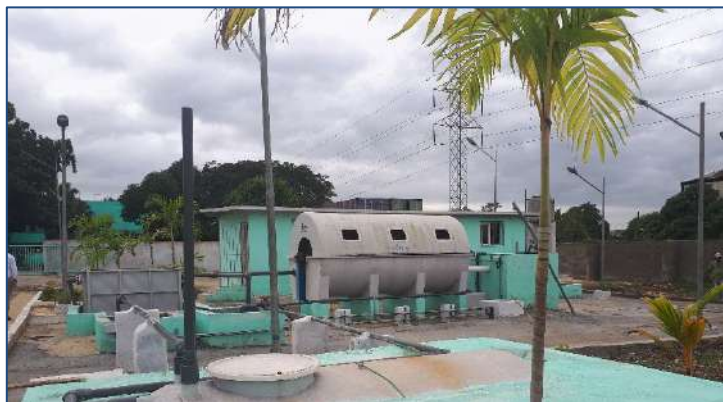
PTAR LABORATORIO REINALDO GUTIÉRREZ (La Habana, Cuba) AÑO: 2016 - Un biodisco. MDL 160-300-3
