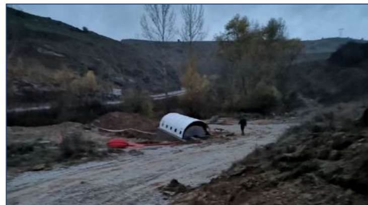
E.D.A.R. SANTIBÁÑEZ DE LA PEÑA – (Palencia, España) AÑO: 2025 – Un biodisco. MDL: 230-400-3
