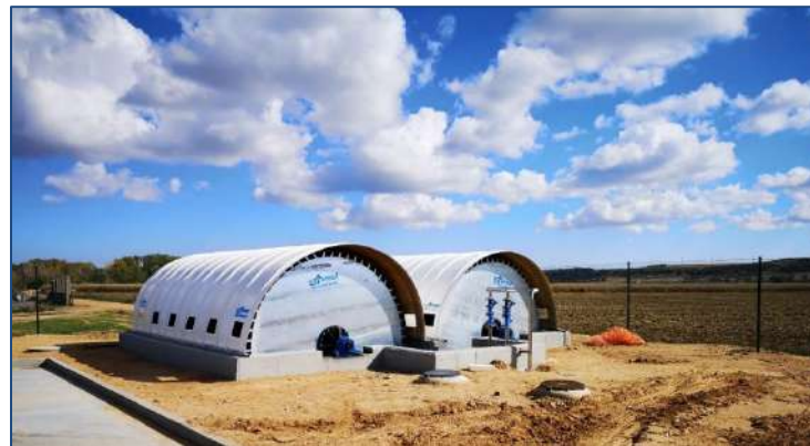
E.D.A.R POLLOS– (Valladolid, España) AÑO: 2024 – Dos biodiscos. MDL: 360-500-4
