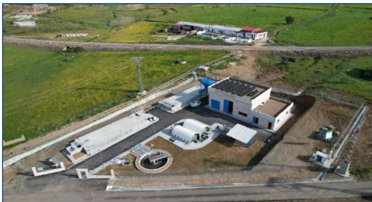
E.D.A.R CASTILBLANCO –(Badajoz, España) AÑO: 2023 - Dos biodiscos. MDL: 360-500-3
