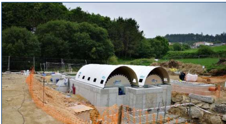
E.D.A.R URDILDE DE ROIS – (A Coruña, España) AÑO: 2024 - Dos biodiscos. MDL: 255-400-3
