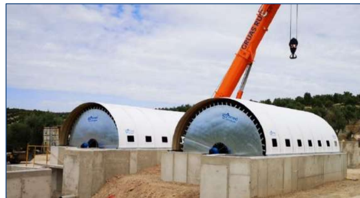
E.D.A.R. BEGÍJAR-LUPIÓN – (Jaén, España) AÑO: 2025 – Dos biodiscos. MDL: 360-650-3
