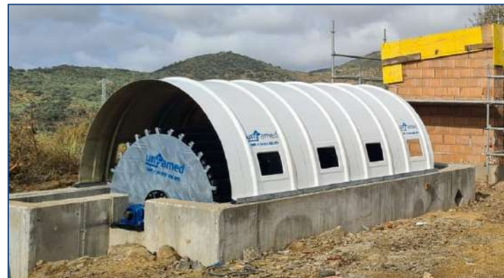
E.D.A.R REINA– (Badajoz, España) AÑO: 2024 – Un biodisco. MDL: 195-350-3
