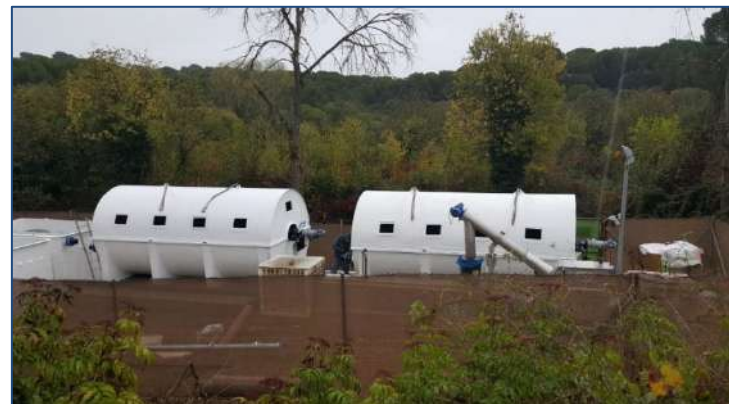
E.D.A.R TRASSIERRA 2 –(Córdoba, España) AÑO: 2022 –Dos biodiscos. MDL: 230-400-3
