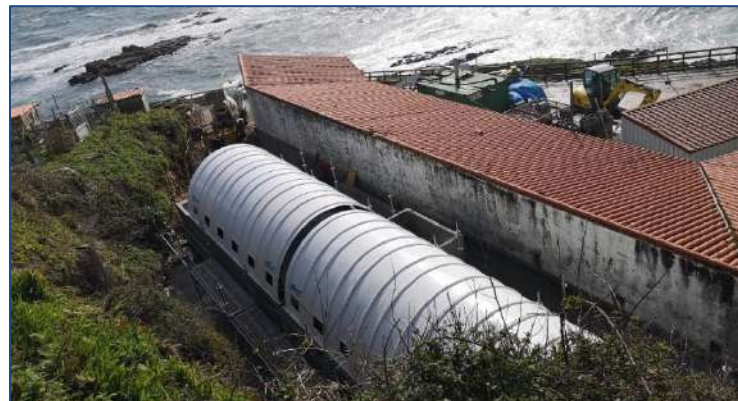
E.D.A.R. ISLA DE ONS – (Pontevedra, España) AÑO: 2025 – Dos biodiscos. MDL: 295-500-3
