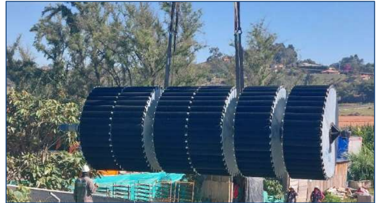
P.T.A.R PLAYA–(Rionegro, Medellín, Colombia) AÑO: 2024 – Un biodisco. MDL: 295-600-4
