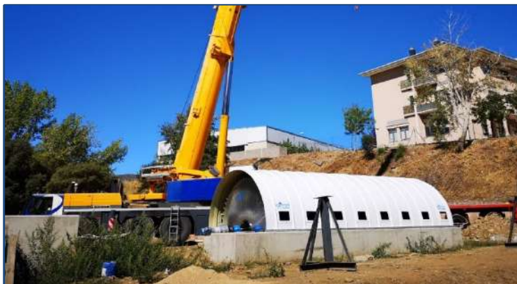
E.D.A.R. PUENTE DOMINGO FLÓREZ – (León, España) AÑO: 2025 - Un biodisco. MDL: 360-700-4
