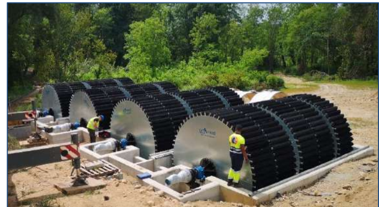
E.D.A.R. MENDO, Salvatierra do Miño (Pontevedra, España) AÑO: 2026 – Cuatro biodiscos. MDL: 360-500-3
