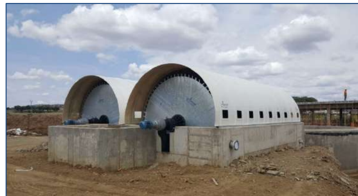
E.D.A.R ROCA DE LA SIERRA –(Badajoz, España) AÑO: 2023 –Dos biodiscos. MDL: 395-700-4
