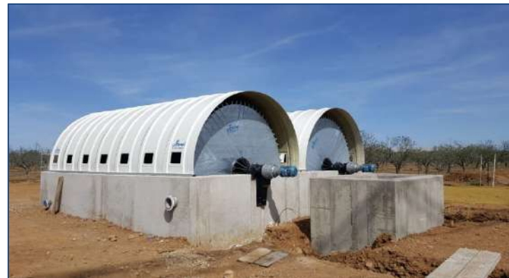
E.D.A.R VILLAGONZALO –(Badajoz, España) AÑO: 2023 – Dos biodiscos. MDL: 395-600-4
