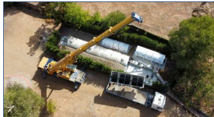
E.D.A.R TRASSIERRA 1 –(Córdoba, España) AÑO: 2022 – Dos biodiscos. MDL: 160-500-3
