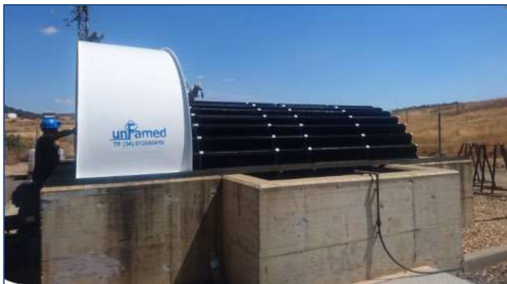
E.D.A.R FONTANAREJO (Ciudad Real, España) AÑO: 2016 – Rehabilitación de un biodisco. MDL 240-450-1
