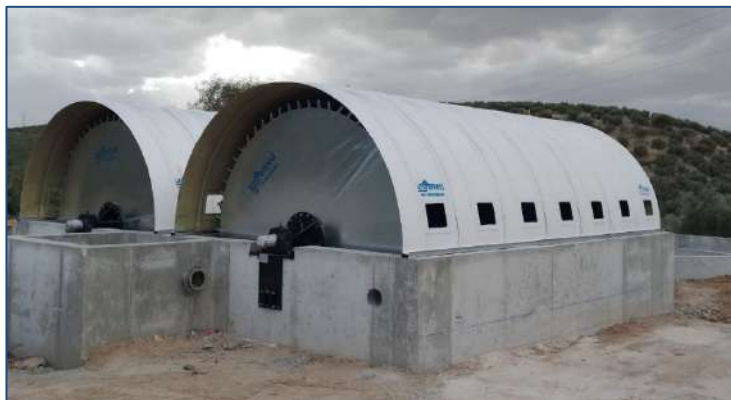
E.D.A.R JAMILENA –(Jaén, España) AÑO: 2023 - Dos biodiscos. MDL: 360-550-3
