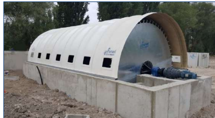
E.D.A.R TORRESANDINO –(Burgos, España) AÑO: 2023 – Un biodisco. MDL: 360-550-4
