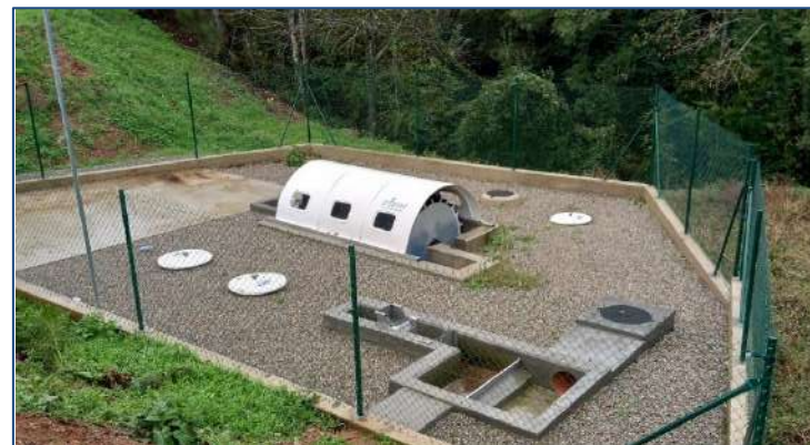
E.D.A.R SEROIRO –(Asturias, España) AÑO: 2023 –Un biodisco. MDL: 160-200-3
