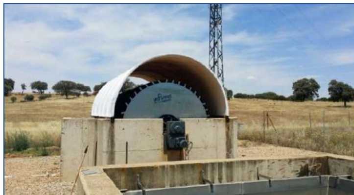
E.D.A.R ALCOBA DE LOS MONTES (Ciudad Real, España) AÑO: 2018 – Rehabilitación de un biodisco. MDL: 255-400-1
