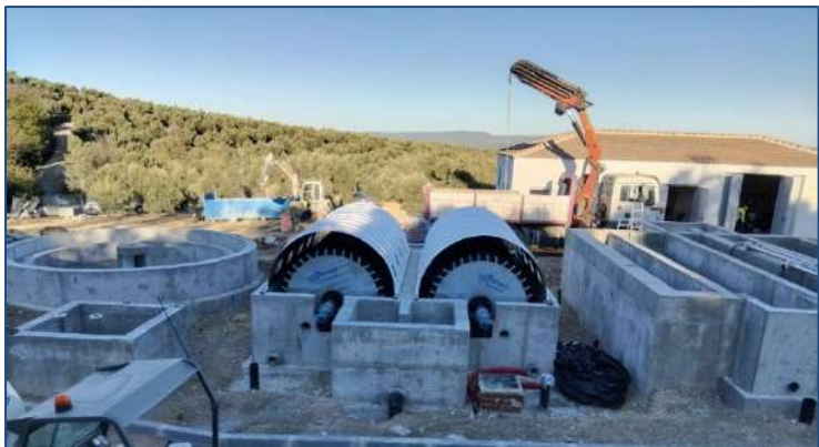
E.D.A.R IZNATORAF – (Jaén, España) AÑO: 2024 - Dos biodiscos. MDL: 230-450-3
