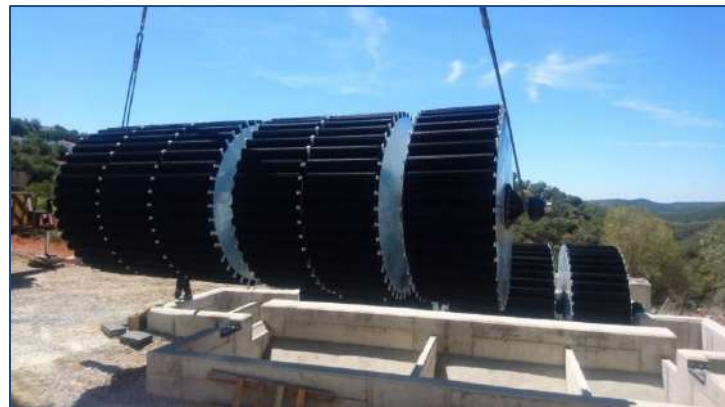
E.D.A.R BERROCAL (Huelva, España) AÑO: 2016 – Dos biodiscos. MDL: 255-600-3
