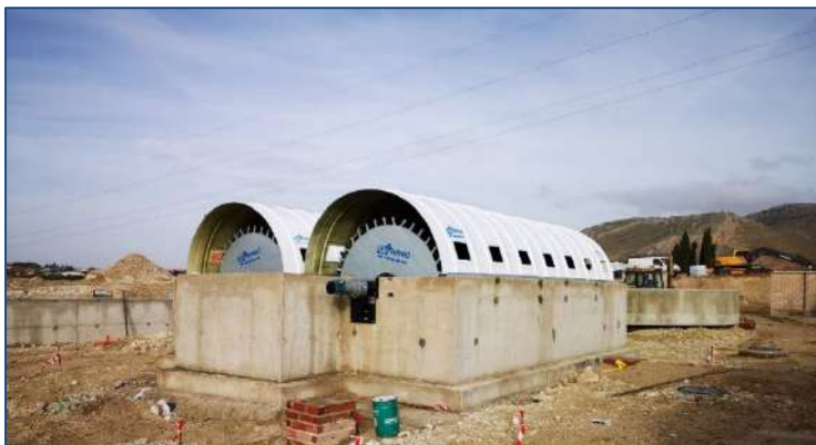
E.D.A.R. PEDRO MARTÍNEZ – (Granada, España) AÑO: 2024 - Dos biodiscos. MDL: 230-600-3
