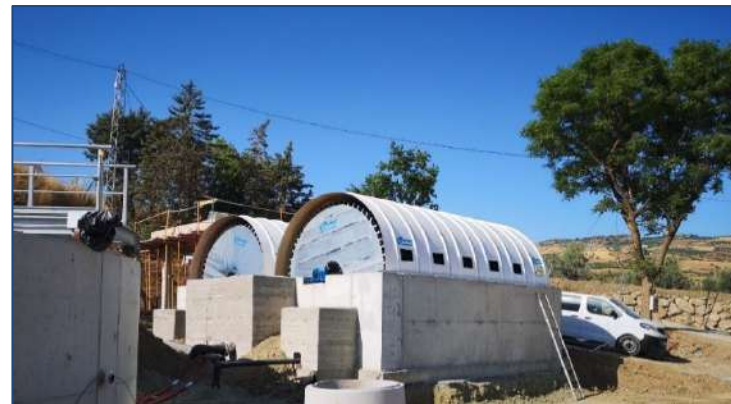
E.D.A.R. ABDALAJÍS – (Málaga, España) AÑO: 2025 – Dos biodiscos. MDL: 360-550-3
