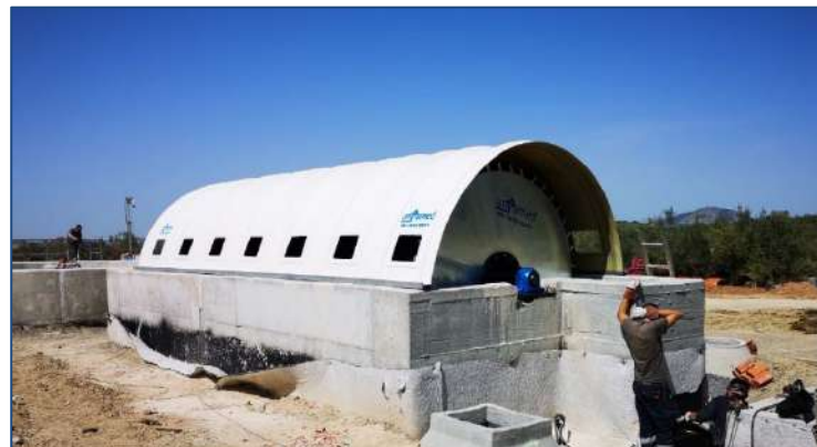
E.D.A.R. FUENTE TOJAR – (Córdoba, España) AÑO: 2025 – Un biodisco. MDL: 255-600-3
