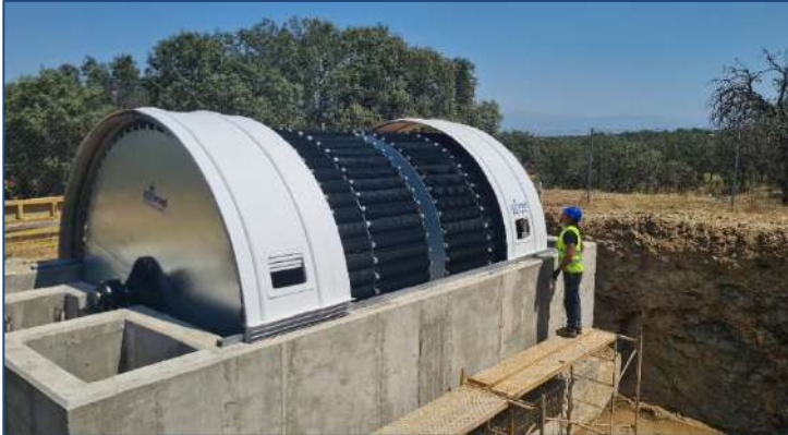
E.D.A.R SERREJÓN (Cáceres, España) AÑO: 2021 - Un biodisco. MDL: 360-450-3..
