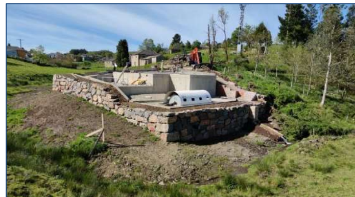
E.D.A.R BERDUCEDO (Asturias, España) AÑO: 2018 – Un biodisco. MDL: 195-350-3
