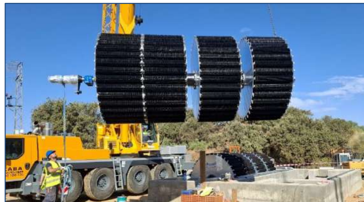
E.D.A.R. FUENTE DEL ARCO – (Badajoz, España) AÑO: 2025 – Dos biodiscos. MDL: 230-400-3
