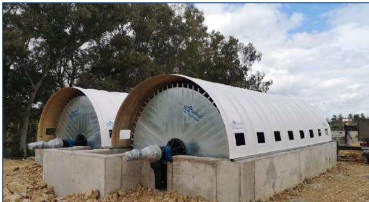
E.D.A.R. ALMENDRAL – (Badajoz, España) AÑO: 2026 - Dos biodiscos. MDL: 360-650-4
