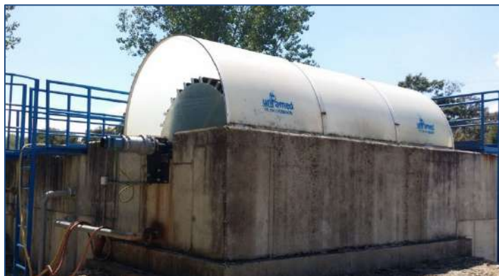
E.D.A.R CARDIEL DE LOS MONTES (Toledo, España) AÑO: 2018 - Un biodisco. MDL 185-300-3
