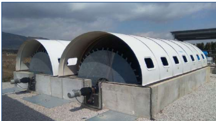
E.D.A.R HONDÓN DE LAS NIEVES (Alicante, España) AÑO: 2014/15 – Dos biodiscos. MDL: 255-500-3
