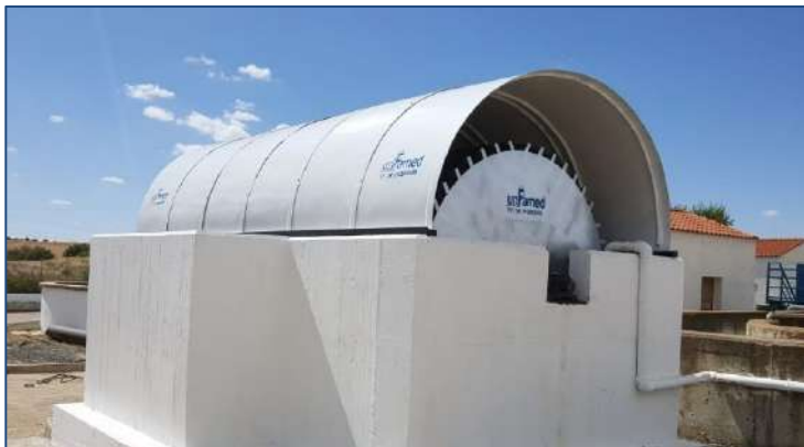
E.D.A.R EL PEDERNOSO – rehabilitación (Cuenca, España) AÑO: 2020 - Rehabilitación de un biodisco..
