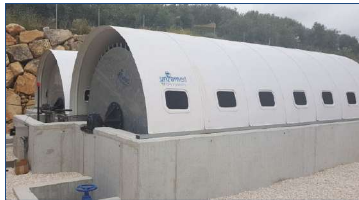
E.D.A.R VILLANUEVA DE TAPIA (Málaga, España) AÑO: 2017 – Dos biodiscos. MDL: 295-575-3
