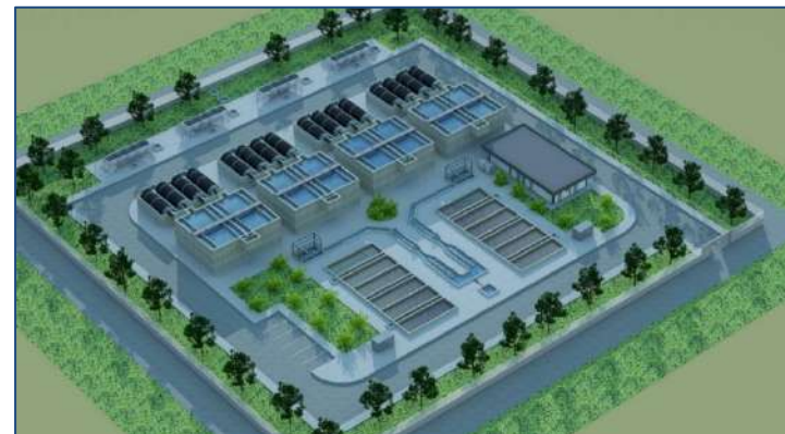
P.T.A.R CÁRDENAS (Cuba) AÑO: 2019 – Suministro material completo depuradora, con 16 biodiscos. MDL: 230-600-3
