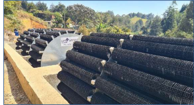
P.T.A.R ABREO DISTRITO 2–(Rionegro, Medellín, Colombia) AÑO: 2024 – Dos biodiscos. MDL: 160-300-1 Y 160-300-3
