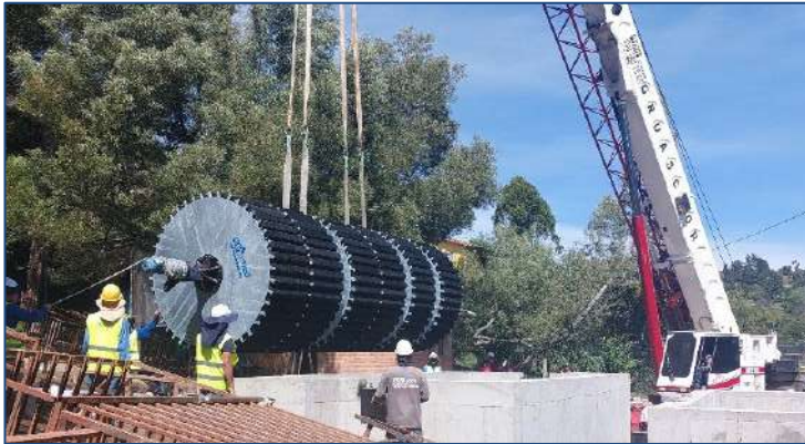
P.T.A.R PEÑALES–(Rionegro, Medellín, Colombia) AÑO: 2024 - Un biodisco. MDL: 295-600-4
