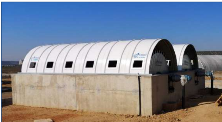
E.D.A.R CAMPILLO DEL RÍO–(Jaén, España) AÑO: 2024 - Dos biodiscos. MDL: 230-550-3
