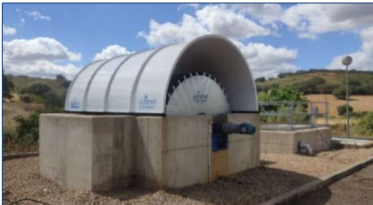
E.D.A.R NAVALPINO (Ciudad Real, España) AÑO: 2022 - Rehabilitación de un biodisco.
