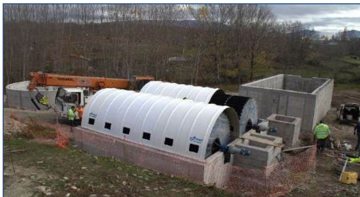
E.D.A.R LAGUNILLA –(Salamanca, España) AÑO: 2023 - Dos biodiscos. MDL: 295-550-3
