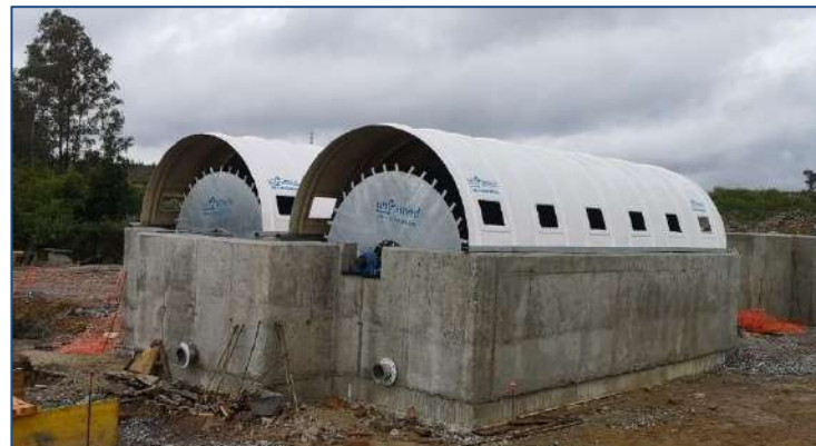
E.D.A.R. CORTEGANA – (Huelva, España) AÑO: 2025 – Dos biodiscos. MDL: 230-500-4
