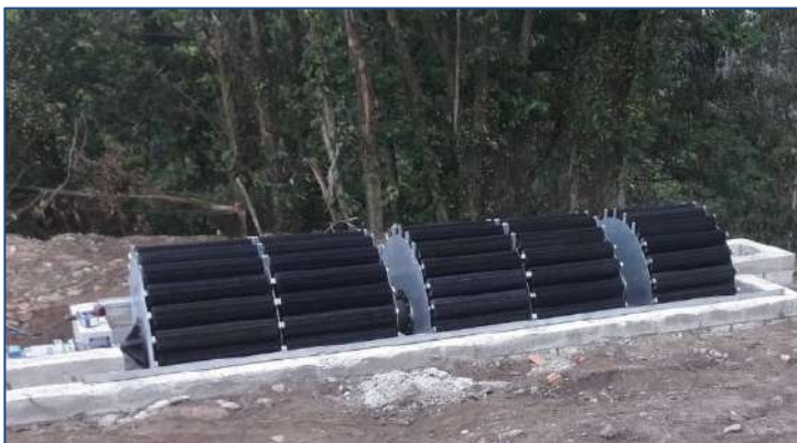
E.D.A.R STA MARINA (Asturias, España) AÑO: 2020 – Un biodisco. MDL: 160-500-3.
