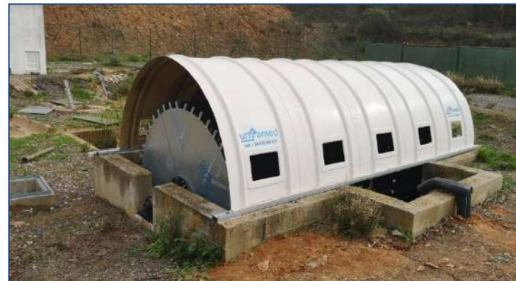
E.D.A.R AUTÓDROMO PORTIMAO –(Portimao, Portugal) AÑO: 2023 – Un biodisco. MDL: 255-500-1
