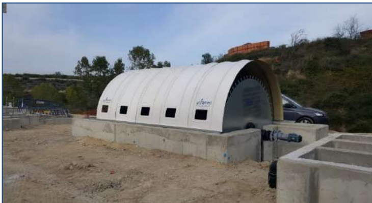
E.D.A.R RAFOL DE SALEM –(Valencia, España) AÑO: 2022 - Un biodisco. MDL: 360-450-3
