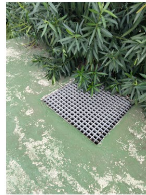
ZONA A INSTALAR
