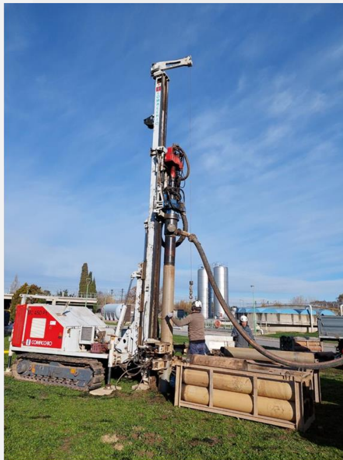
Construcción de los puntos de control
