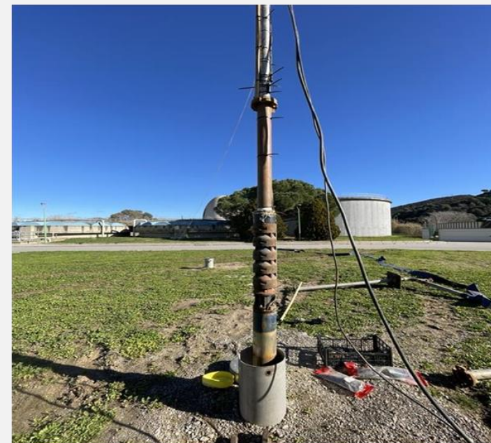
Ensayos de bombeo
