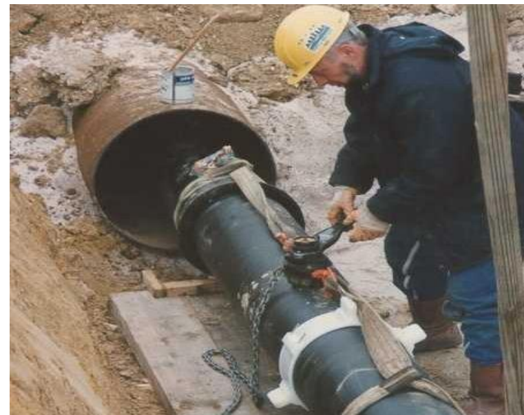
INSTALACIÓN SIN ZANJA
