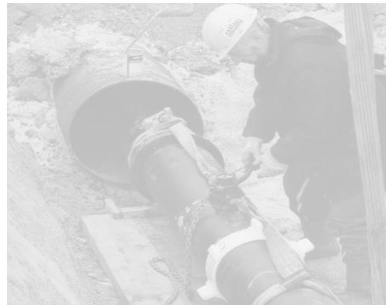
INSTALACIÓN SIN ZANJA
