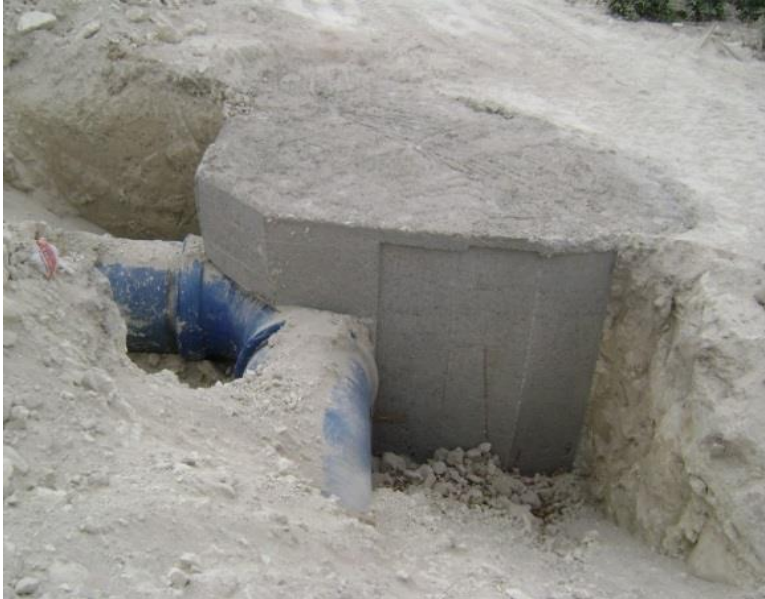
ELIMINACIÓN MACIZOS DE ANCLAJE
