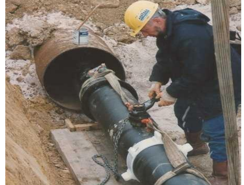
INSTALACIÓN SIN ZANJA
