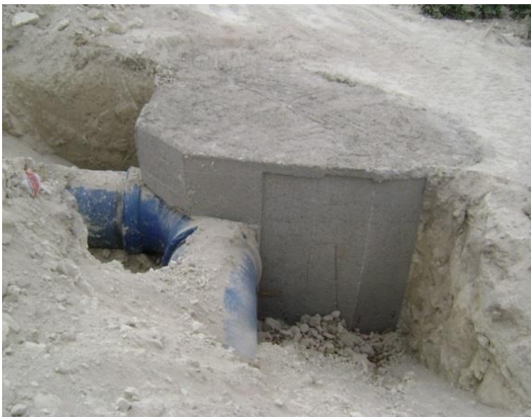
ELIMINACIÓN MACIZOS DE ANCLAJE
