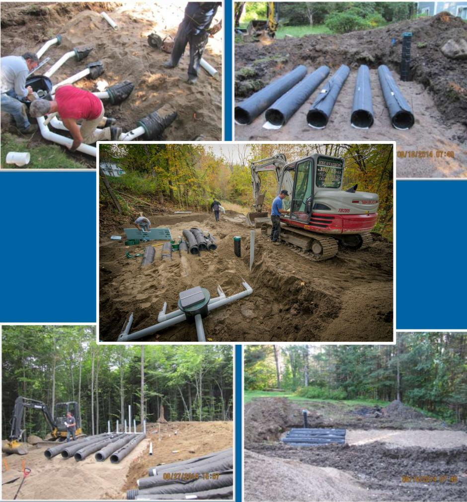
Ejemplos de configuración por encima de la cota del terreno natural
