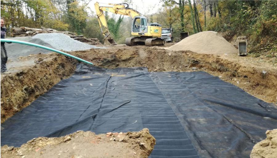
Membrana impermeable en base de la instalación
