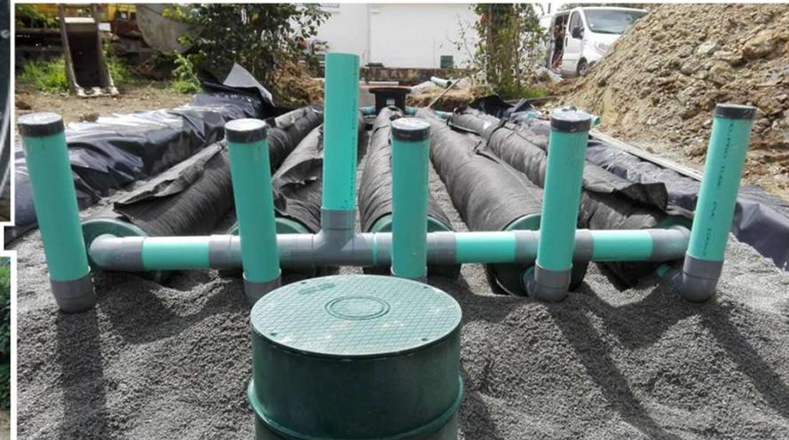
*Ventilación y piezómetros*
