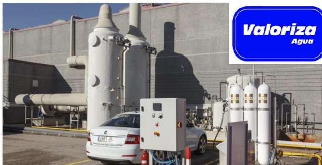
Presentan un prototipo que reutiliza el gas de los lodos de la depuradora como combustible para los vehículos
